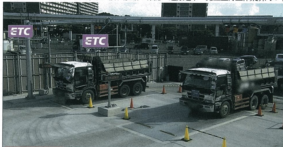
写真-2 ETC アンテナ設置状況 (発生土再生作業所への受入)
